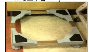
●うがい器が設置しているため、給水/排水共に配管あり。給水はアングル分岐水栓を接続。排水は排水管に合流チーズを接続する。この時、排水管が高い位置(440mm)にあるためかさ上げ台を使い設置する。(かさ上げ台95mm)
