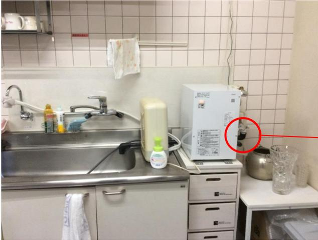
●給湯器の給水にアングル分岐水栓で接続する。
